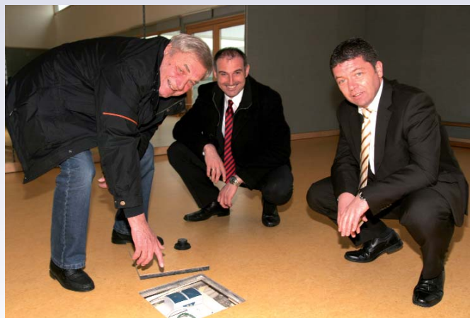
(V. l. n. r.) Theodor Thönnissen, Ernst Ewald und Peter Felbermeier zeigen, wo das Wasser in den Schwingboden der Gymnastikhalle lief und die Elektrik außer Gefecht setzte. Foto: rds
